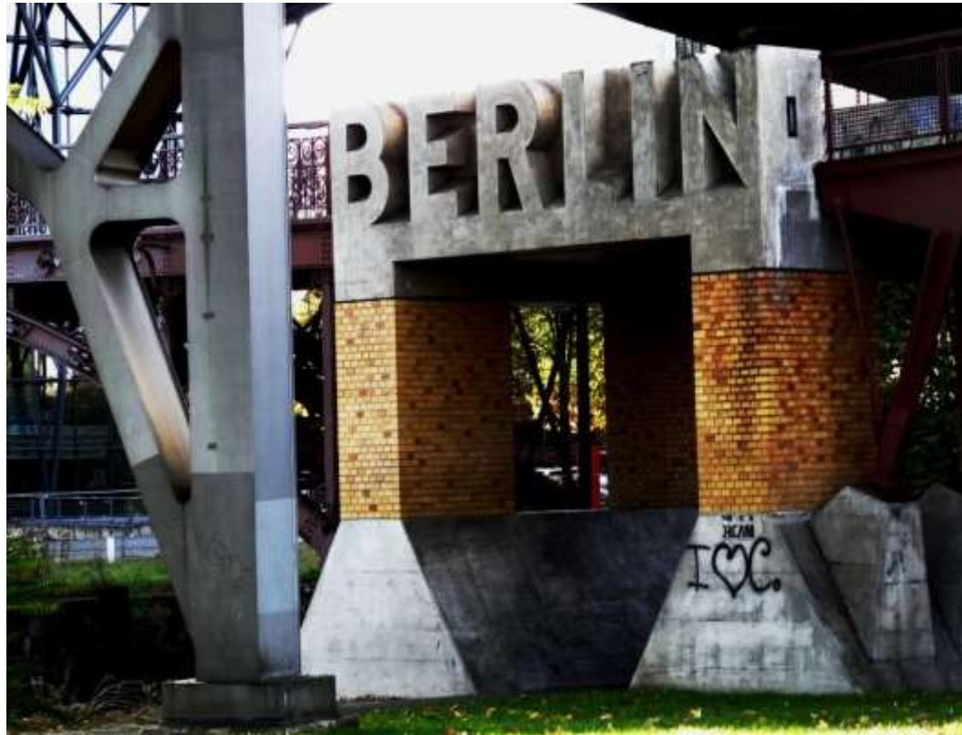
anhalter steg, nähe möckernbrücke
